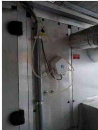
Remotair®, il sistema di monitoraggio da remoto degli impianti HVAC di **ALISEA**, esegue il controllo delle unità di trattamento aria e delle condotte, grazie a un nucleo di Intelligenza Artificiale Cloud-based e all'utilizzo di dispositivi avanzati per la registrazione puntuale dei parametri microclimatici e di eventuali anomalie. In aggiunta, mediante l'elaborazione di immagini ad alta risoluzione,
